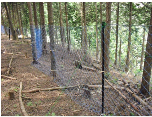
防護柵（ネット）
