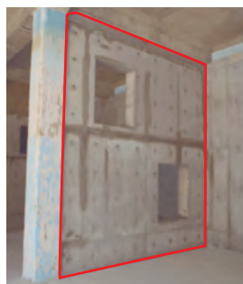
耐震壁設置後
