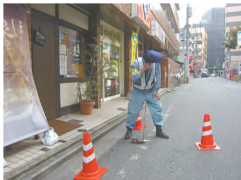
音聴棒を使用した漏水調査
