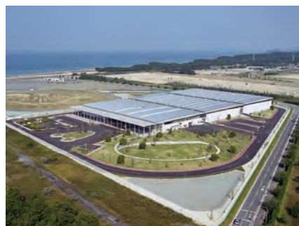
海水淡水化センター
