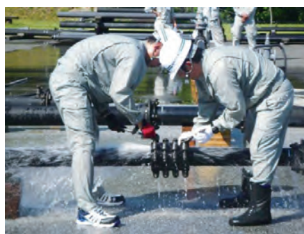
漏水修理の実習
