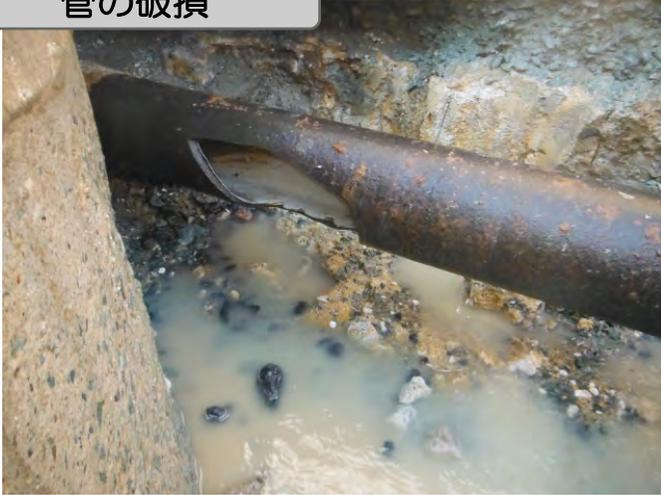
漏水による陥没
