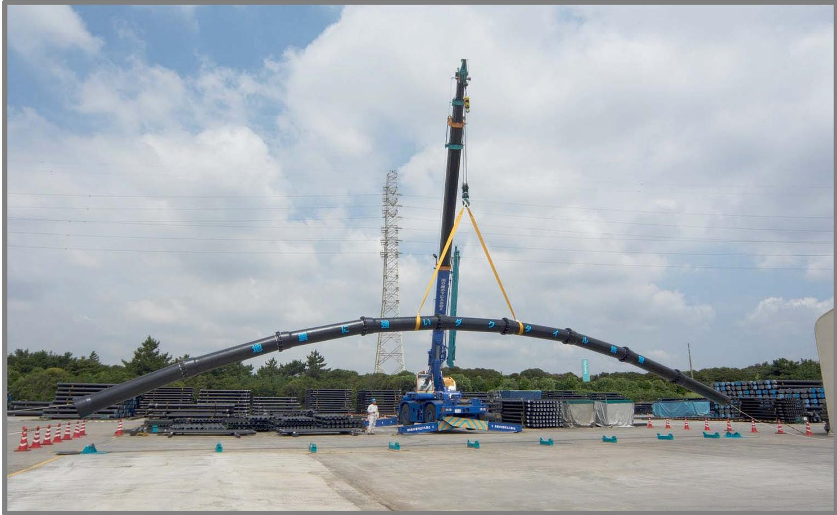
更新の際は、管の継ぎ目が柔軟に追従し、地震のゆれに強い耐震管を採用
