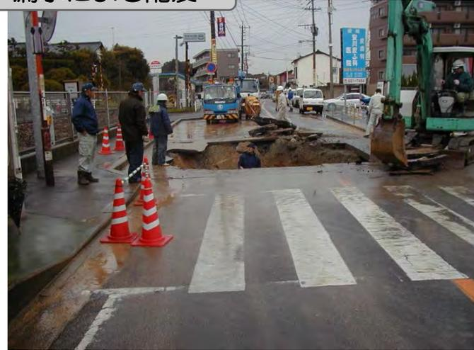
漏水による陥没・冠水
