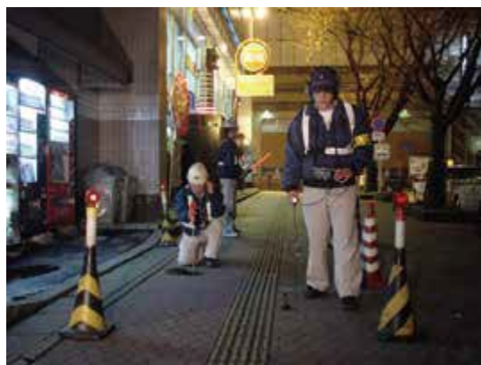
漏水探知機を使った漏水防止調査
