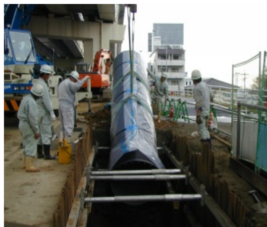
老朽化した配水管の取替工事
