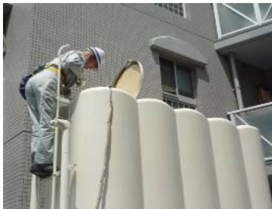
貯水槽の点検・調査
