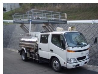
羽根戸配水場の注水設備と給水車
