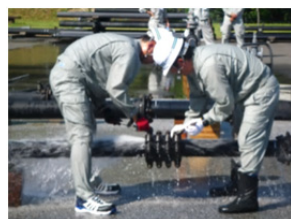
水道技術研修所での 漏水修理の実習
