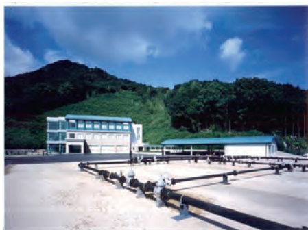
福岡市水道技術研修所
