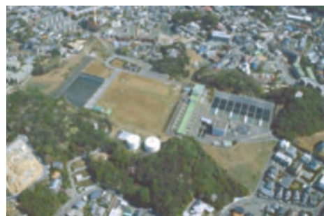
福岡市で最も古い高宮浄水場
