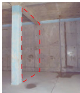
耐震壁設置前
