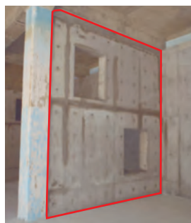
耐震壁設置後
