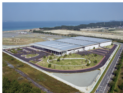
海水淡水化センター
