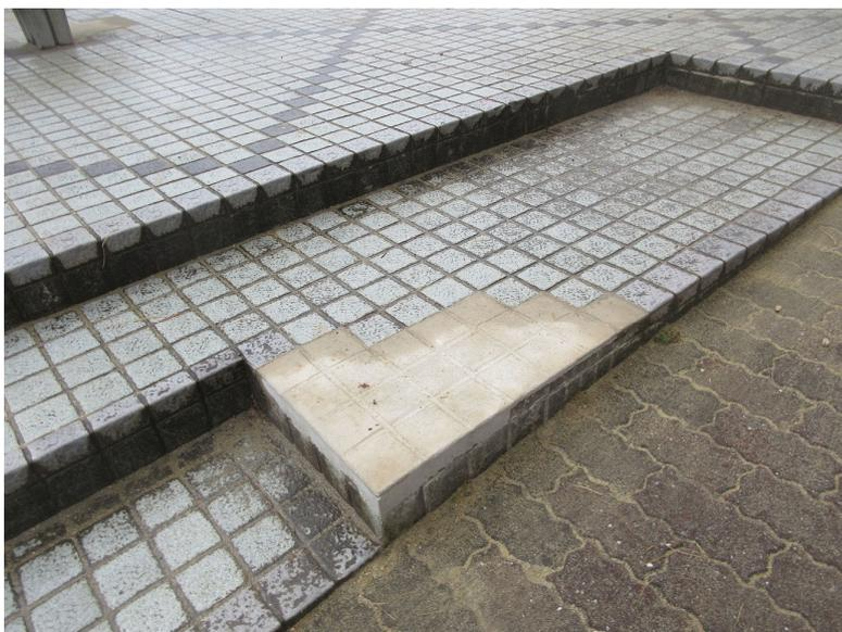
スケボーに壊されたタイル舗装をモルタルで修理
