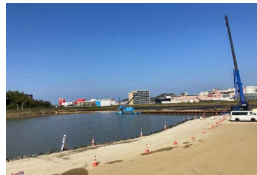
現場状況写真 （令和4年11月時点）
