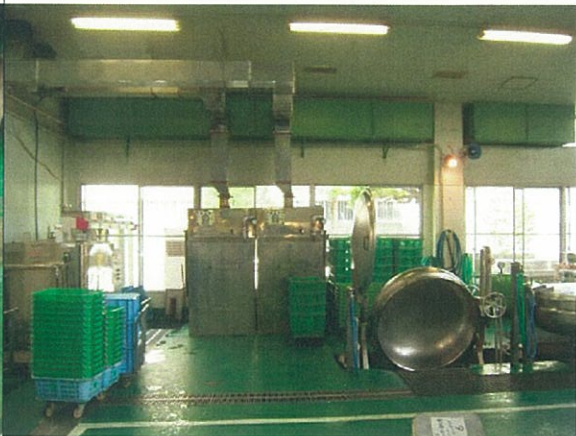
2:露出ダクトが多く、埃溜りとなっている
