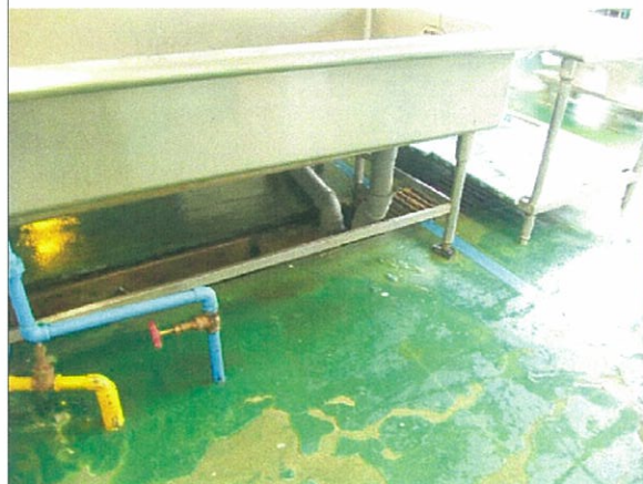
5:排水時のオーバーフローの対策については不明だが可能性が懸念される。床の磨耗も見られる
