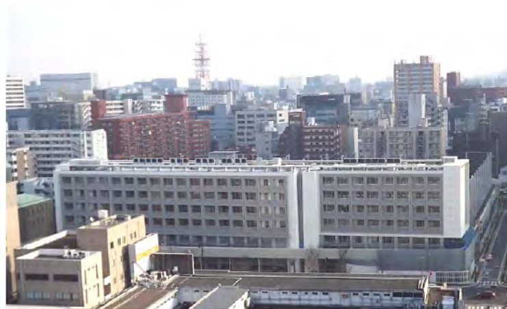
校舎全体（北側）
