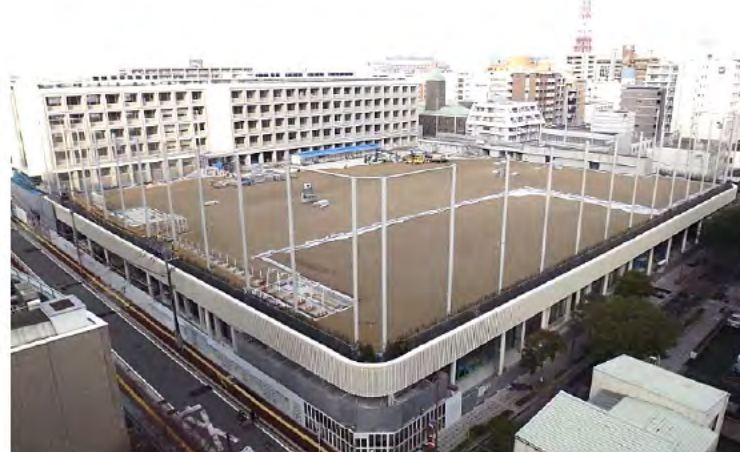
校舎全体（南西側）
