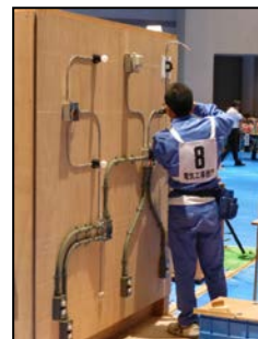
《ものづくりコンテスト (電気工事部門)》
