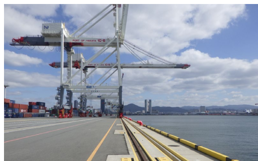
係留施設(岸壁)
