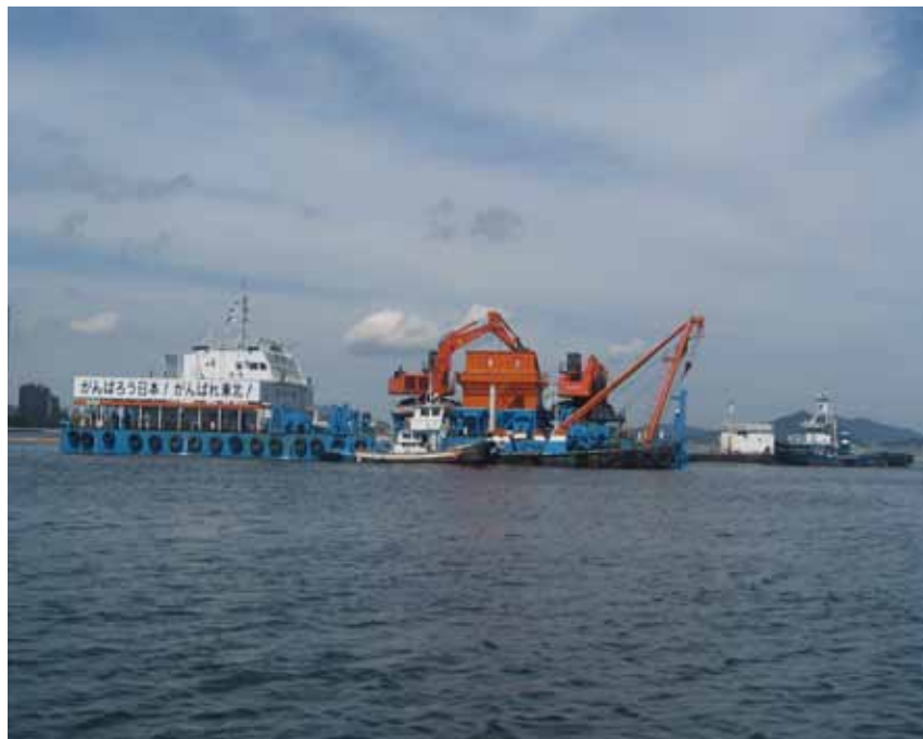
百道沖の窪地埋め戻し工事
