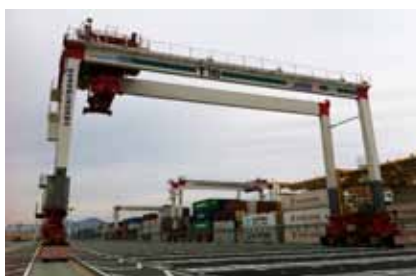
トランスファークレーンの全面電動化 （アイランドシティ地区）
