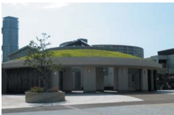
屋根を緑化したトイレ
