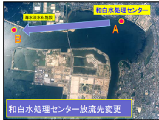
図 4 9 和白水処理センターの放流先変更
