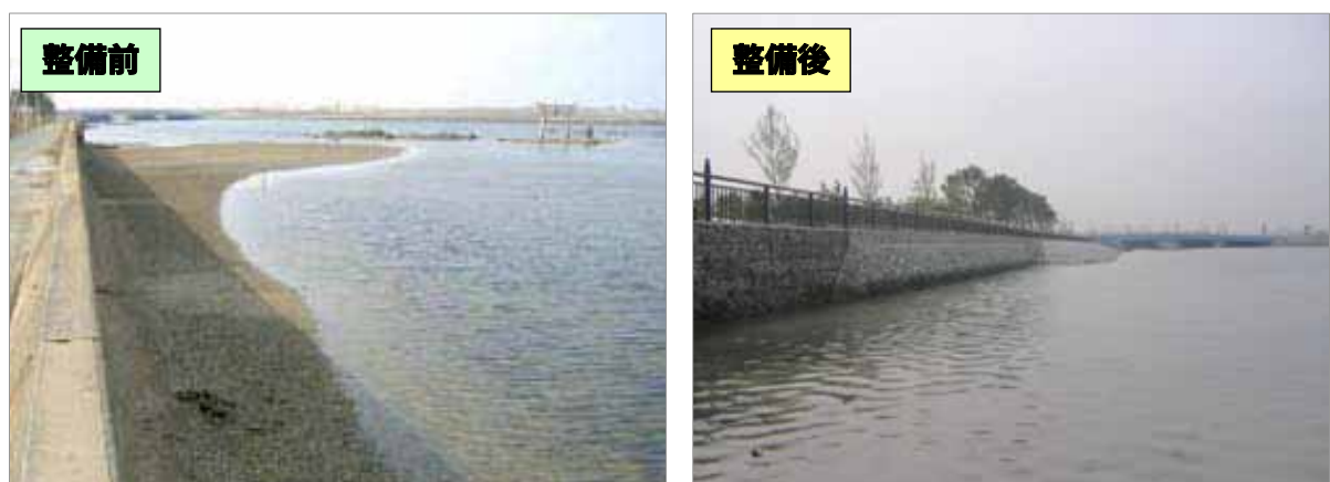
写真 2 7，2 8 香椎浜地区の護岸整備
