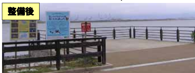
写真40, 41 整備された展望台及び遊歩道
