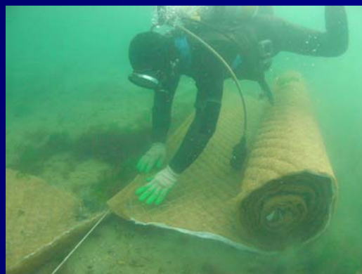
播種シート設置作業
