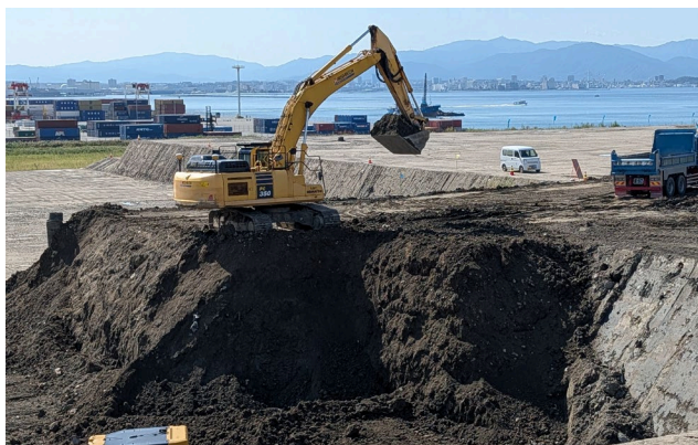
二次覆土撤去（市4の3工区）
