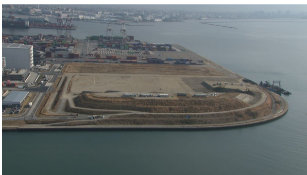
二次覆土撤去（市4の3工区）
