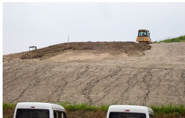
二次覆土撤去（市5の3工区（西側））
