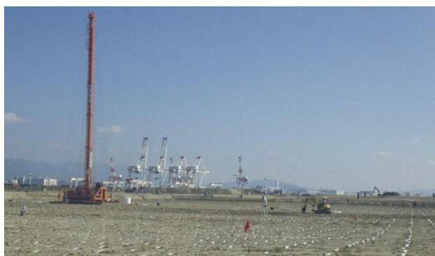
市4の3工区 地盤改良（ドレーン工）
