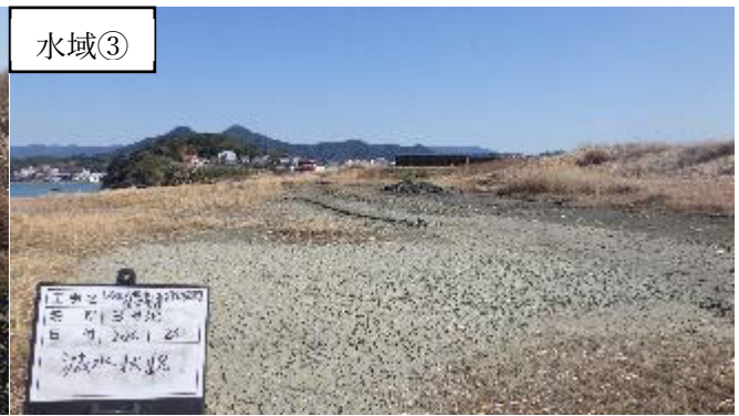
図 2 2 令和 7 年度 1 月減水状況写真
