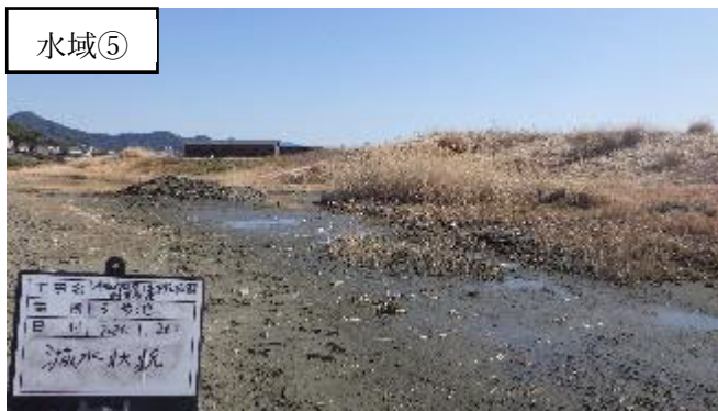
図 2 3 令和 7 年度 1 月減水状況写真
