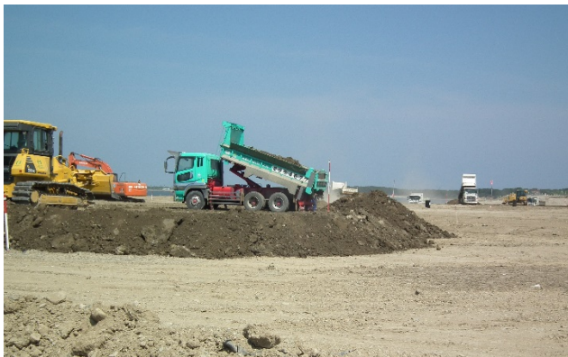
市3の2の2工区 地盤改良（二次覆土）
