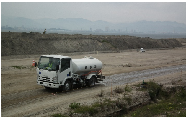
工事区域内の散水
