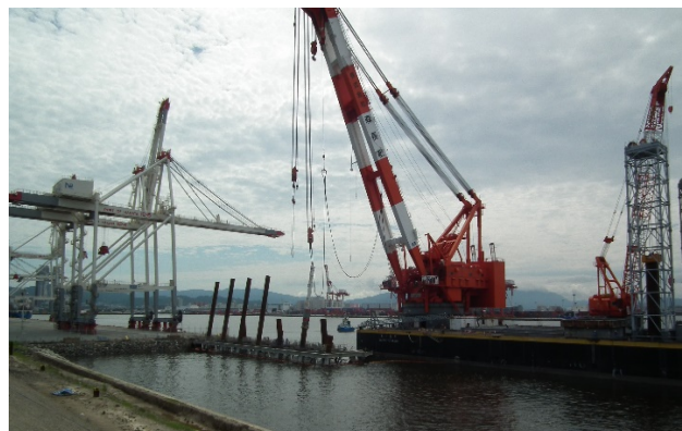
岸壁（-15m）岸壁築造（鋼管杭打設）
