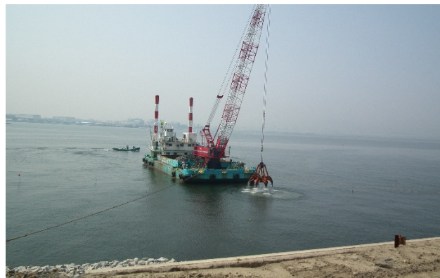
岸壁（-15m）岸壁築造（基礎捨石）
