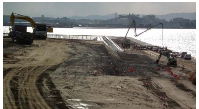
市3の2の2工区 A護岸築造 (上部工)
