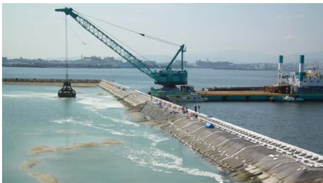
市3の2の2工区 A護岸築造 (腹付工)
