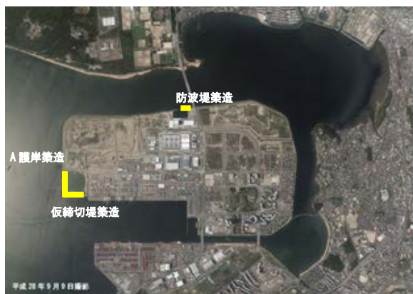
図5 平成28年度の海上工事
