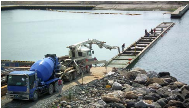
市2工区 防波堤築造 (上部工)
