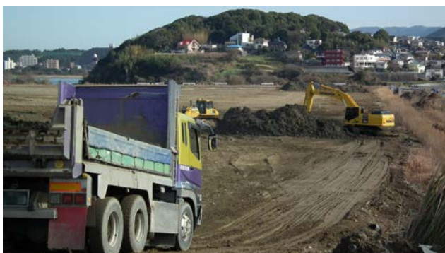
市5の3工区 (間仕切堤撤去工事)
