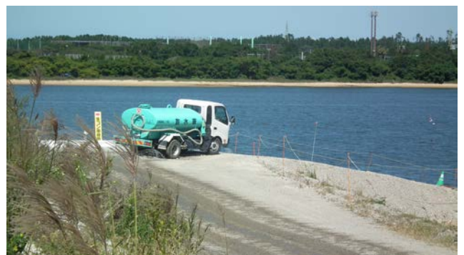
工事区域内の散水
