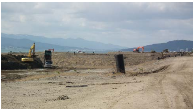
市4の1工区 地盤改良 (覆土撤去)
