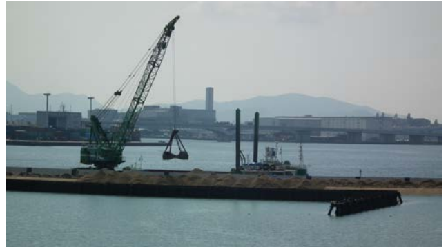
市3の2の2工区 仮締切堤築造 (腹付工)
