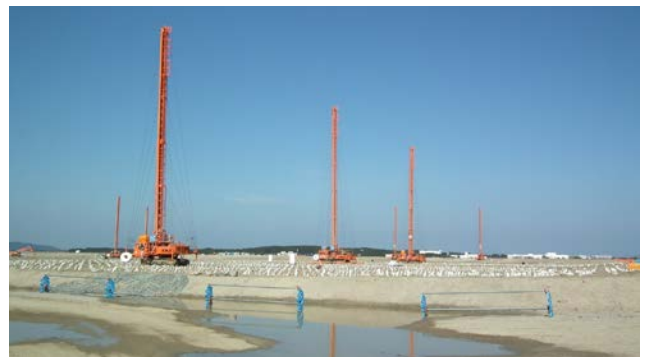
市4の3工区 地盤改良 (ドレーン工)
