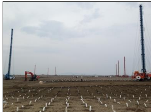
市4の1工区の地盤改良（ドレーン）
