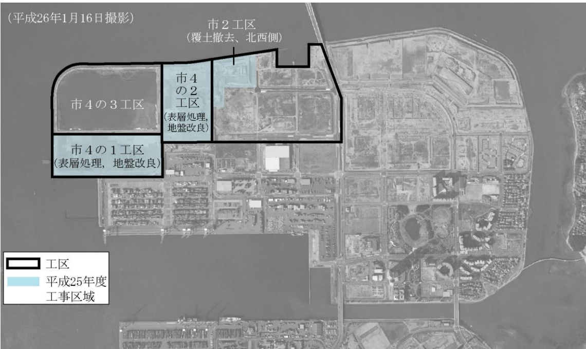
図 1 平成 25 年度工事箇所
