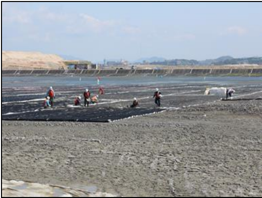
市4の2工区の表層処理（補強材敷設）
