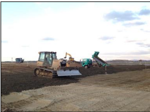
市4の1工区の地盤改良（一次覆土）
