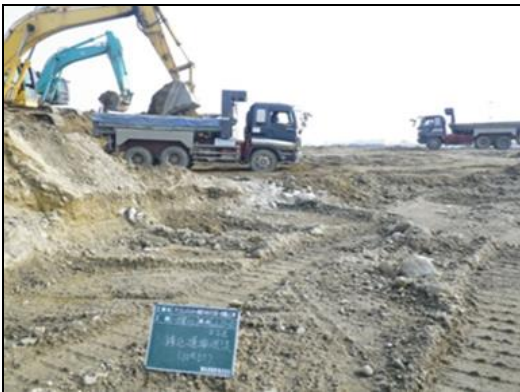
市2工区の覆土撤去
