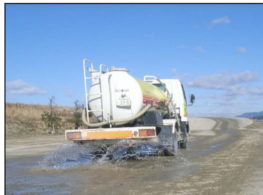
工事区域内の散水
