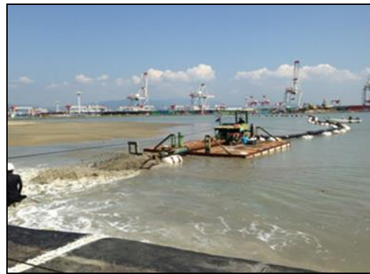
市4の1工区の表層処理（敷砂）
