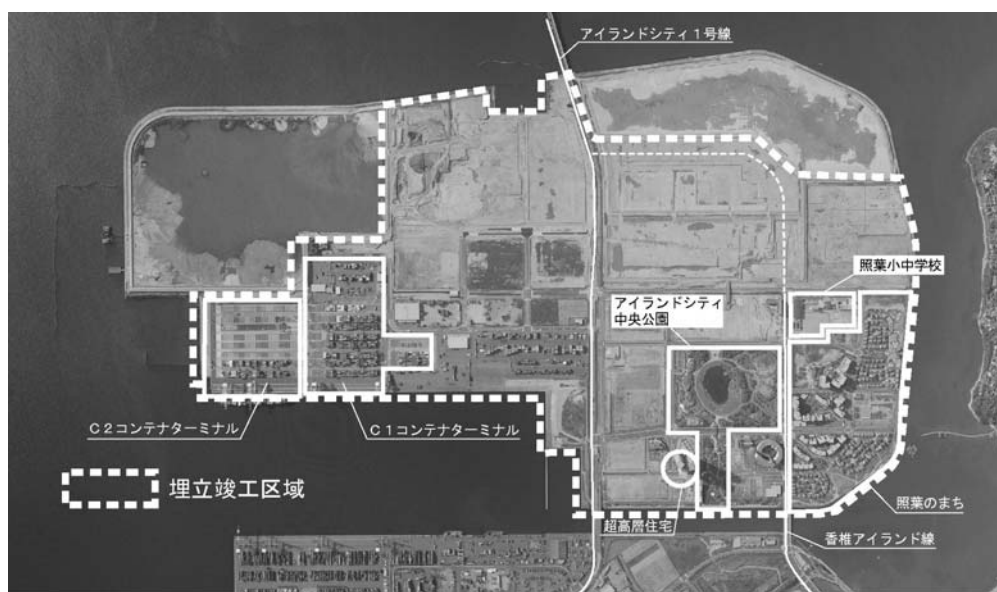
事業の進捗状況（平成 22 年 5 月 7 日撮影）
