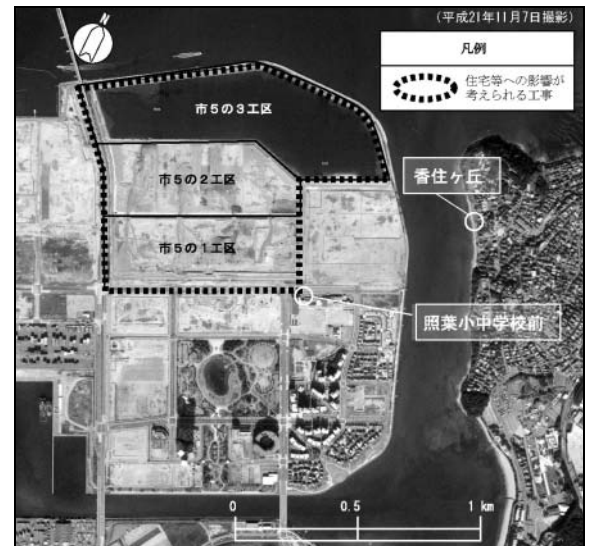
図2 調査地点と騒音に係る工事状況
