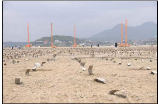
市5の2工区のドレーン工
