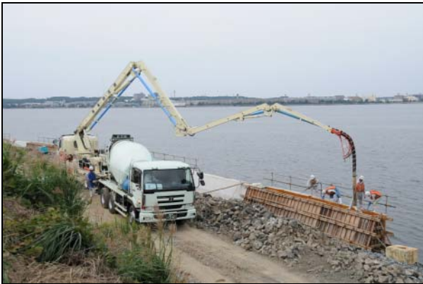
市5の3工区の護岸施工
