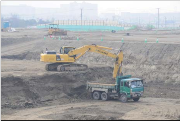
市5の1工区の覆土撤去
