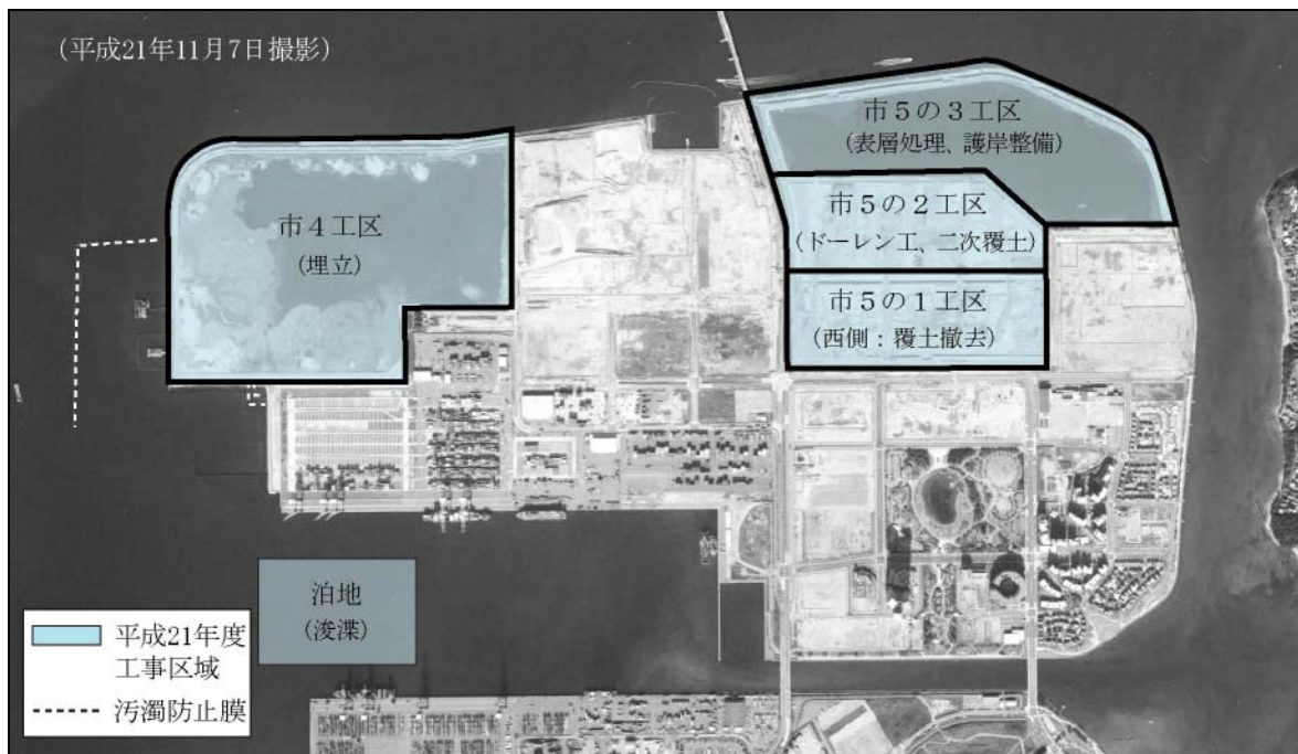
図 1 平成 21 年度工事箇所
