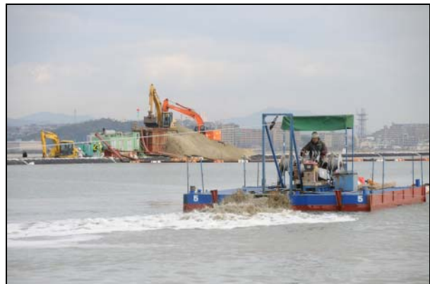
市5の3工区の表層処理（敷砂工）
