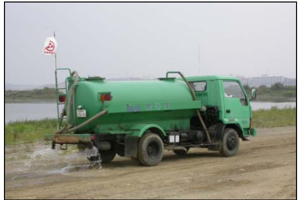
工事区域内の散水
