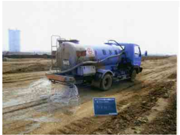
工事区域内での散水
