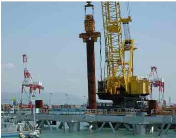
国岸壁工事の鋼管杭打設
