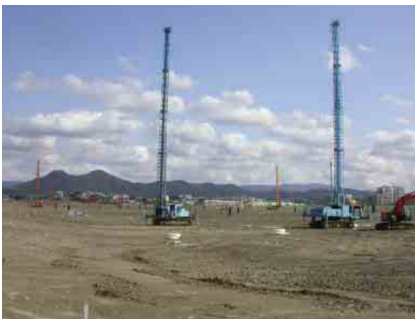
市5の1工区のドレーン打設
