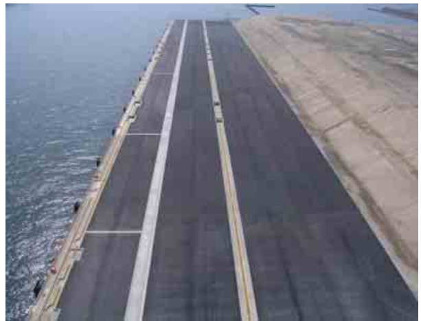
国岸壁工事（完成）
