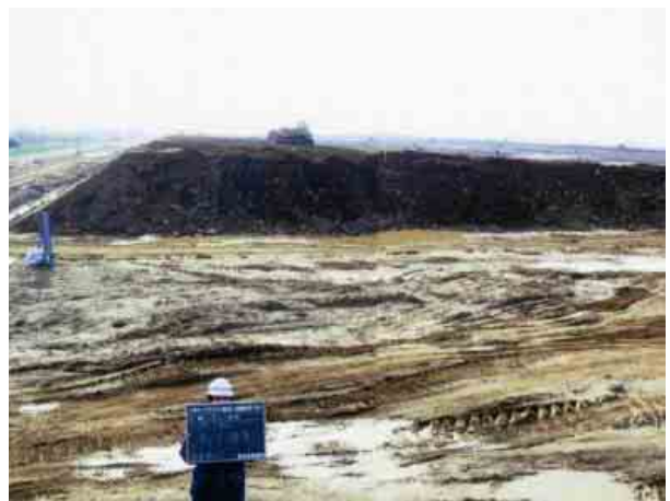
市5の1工区の盛土
