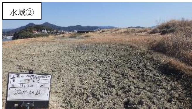
図 2 1 令和 7 年度 1 月減水状況写真
