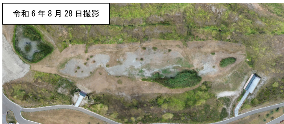
図18 減水状況・水域全景
