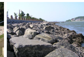
＜生きものの生息に配慮した護岸＞
