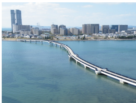
<海上遊歩道(あいたか橋)>
