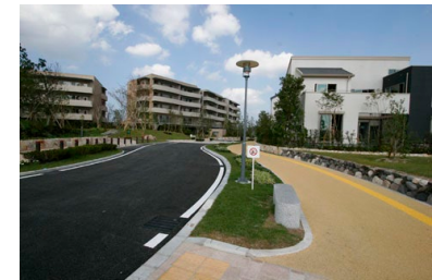
写真 4-2-4 汎用性の高い素材使用による維持管理へ配慮した道路整備の取組み
