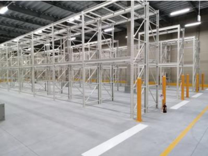
パレットに積んだ貨物を保管するラック
