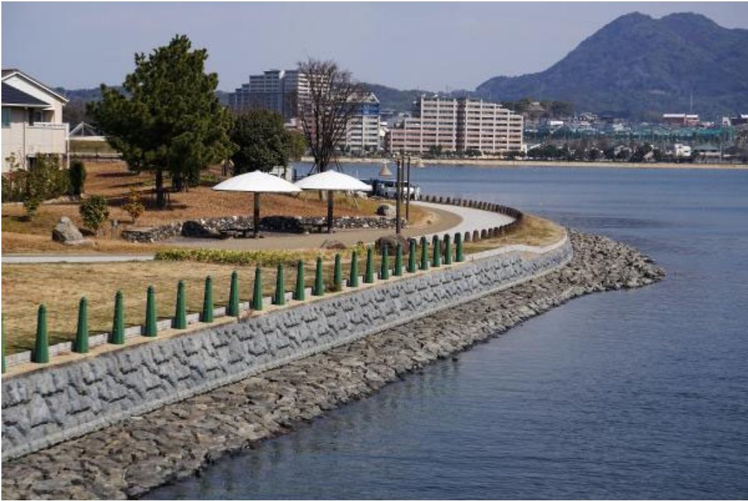
アイランドシティ外周の自然石緩傾斜護岸
