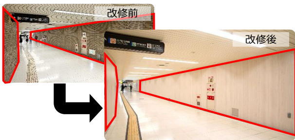
駅コンコース壁面改修
