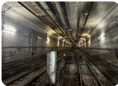
トンネル内照明のLED化
