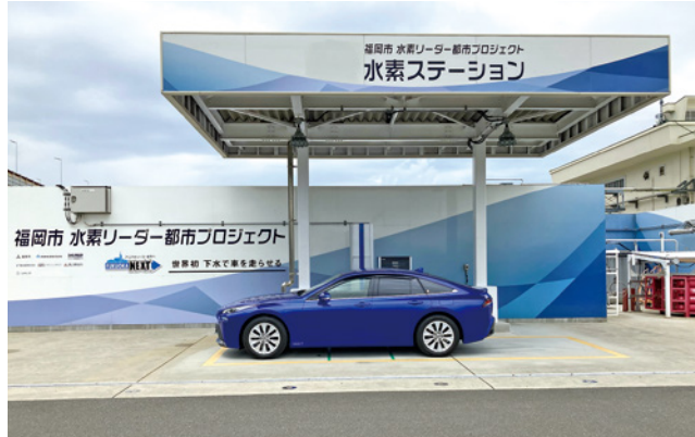
福岡市水素ステーション
