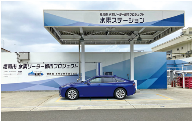
福岡市水素ステーション
