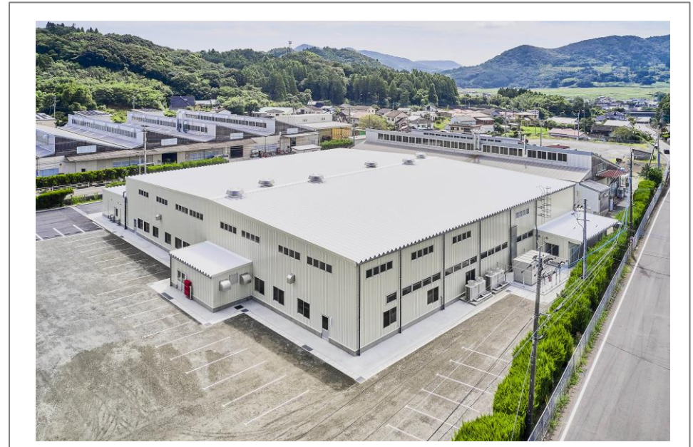
テラル多久第三工場新築工事（2023年9月完成）佐賀県多久市
