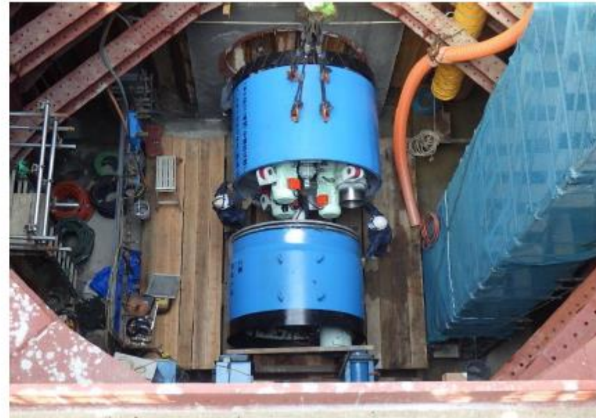
【推進機接続状況】
