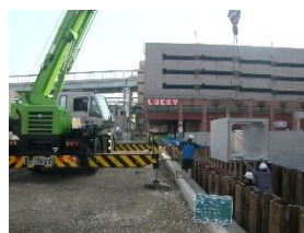
(水路付替え工事)
