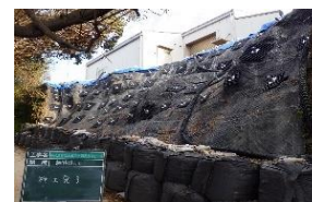
(災害復旧工事)
