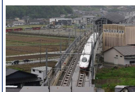
【軌道】軌道新設 西九州新幹線武雄工区軌道
