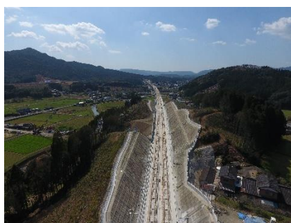
【土木】路盤新設 西九州新幹線大山地区路盤新設
