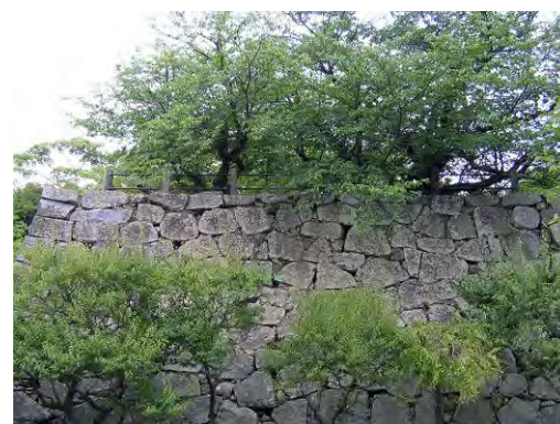
写真 2-76: [28] 時櫓跡石垣を見る 特徴的な石垣の景を間近で見ることができるが、手前に生育する樹木が視線を遮蔽している。
