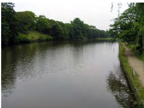
写真 2-60: [12] 上之橋より西方方向を見る 東西に延びる堀のほぼ全容を見ることができる。土塁は樹木が覆いかぶさり見えづらい。
