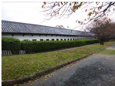
写真 4-9: 樹木整理前の多間櫓
