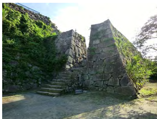
写真 2-80: [32] 鉄御門跡を見る 石垣と石垣に挟まれた天守台へと繋がる往時の道を見ることができる。
