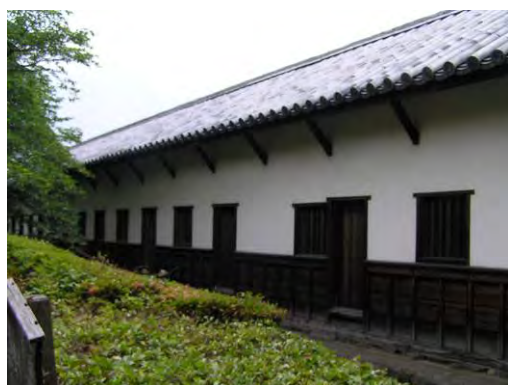
写真 2-75: [27] 多聞櫓を見る 多聞櫓を間近に見ることができるが、手前の低木や樹木により一部視線が遮蔽されている。
