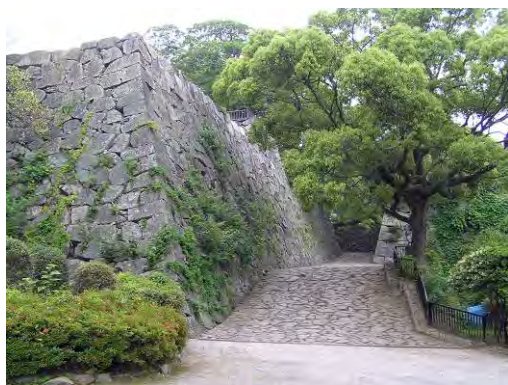
写真 2-74: [26] 本丸裏御門より武具櫓御門方向を見る 本丸へと繋がる道と道沿いの石垣を一体的に見ることができる。
