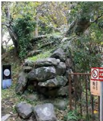
写真2-25: 壊されたままの石垣 (三ノ丸、名島門南)
