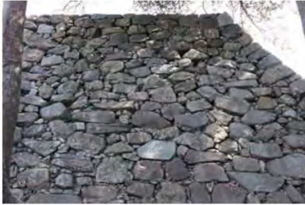
写真2-17:A類(天守台)
