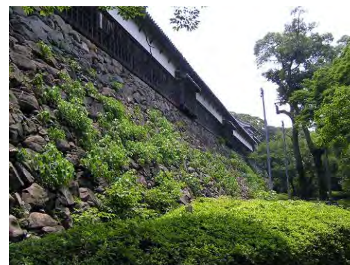
写真 2-68: [20] 多聞櫓を見る 福岡城跡で唯一の重要文化財である多聞櫓と石垣を間近で見上げることができる。
