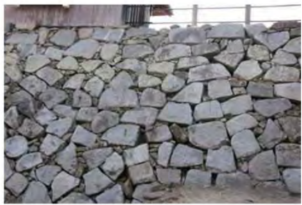
写真2-20:D類(祈念櫓跡)
