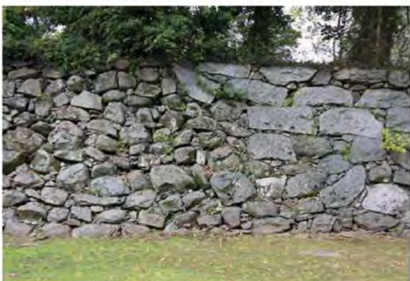
写真2-30: 生捕櫓跡の石垣
