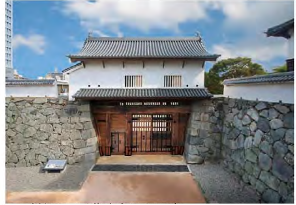
写真2-10: 下之橋御門 (県指定有形文化財)
