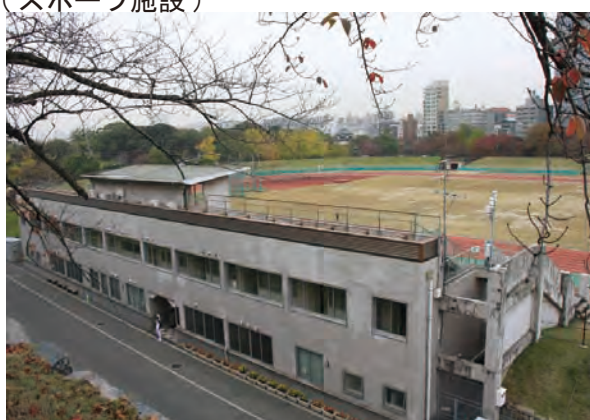
写真 -4 平和台陸上競技場
