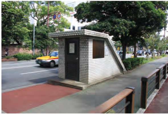
写真 -9 内堀外壁石垣展示室
