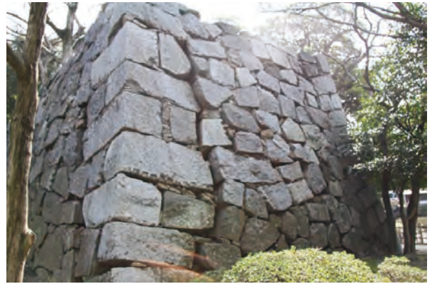
写真-2 ずれと孕み(鉄物櫓)
