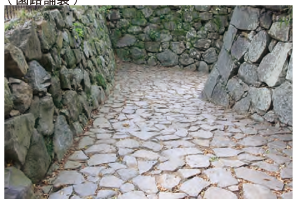
写真-22 二ノ丸武具櫓御門の通路の自然石舗装 (照明)
