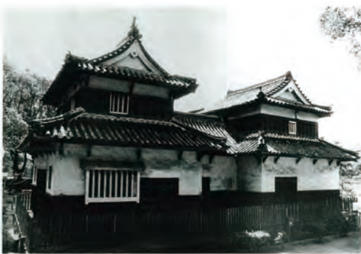
崇福寺仏殿として使われていた潮見櫓と 花見櫓（県指定有形文化財） ※現在は解体され、部材を福岡 市で保管している。
