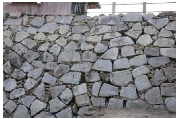
写真-4 D類、乱層積み(祈念櫓)
