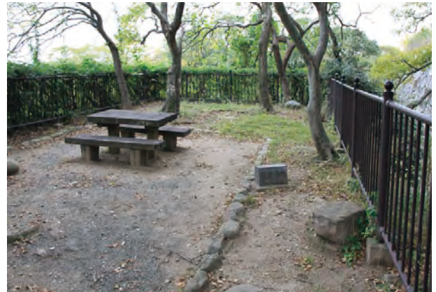
写真-18 鉄砲櫓跡のベンチ・縁石・名称板・柵 (駐車場)
