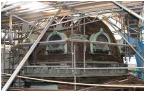
旧日本生命保険株式会社九州支店の屋根修理
