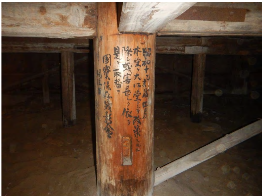
床下 柱取替え材 昭和 10 年墨書 「昭和十乙亥歳四月／ 本堂ヲ大師堂トシテ改 築スルニ／際シ蟻害甚 シク依テ／是ヲ取替テ ／國寶保存会顕彰會／ 現住■・・・」
