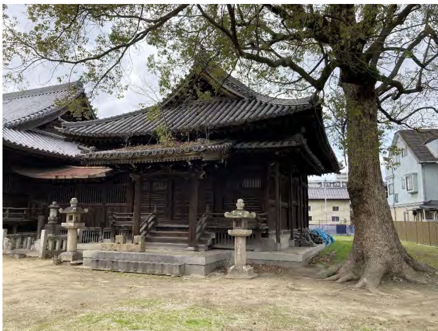
外観 正面、側面（東面）
