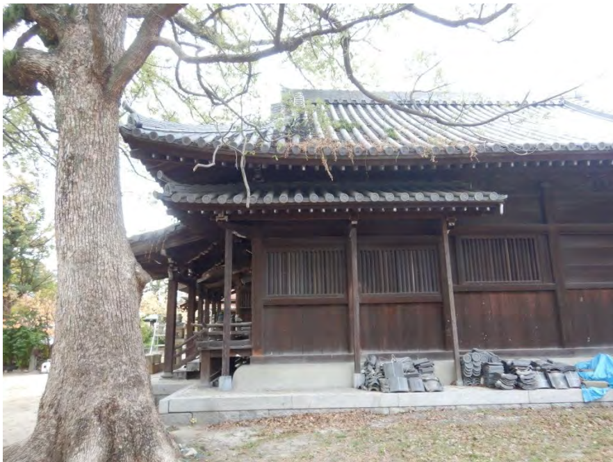
外観 側面（東面）
