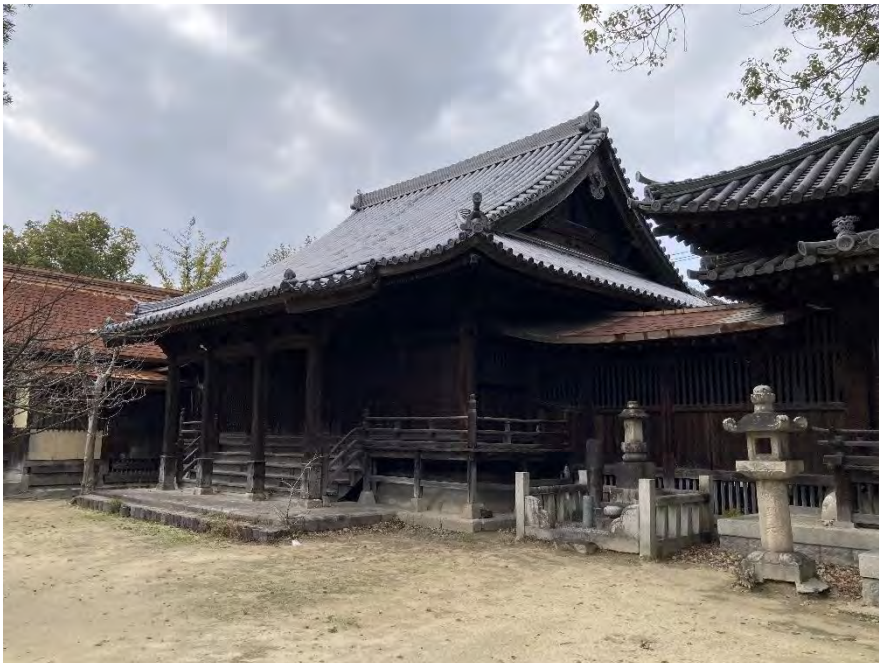
外観 正面、側面（東面） 渡り廊下（南面）
