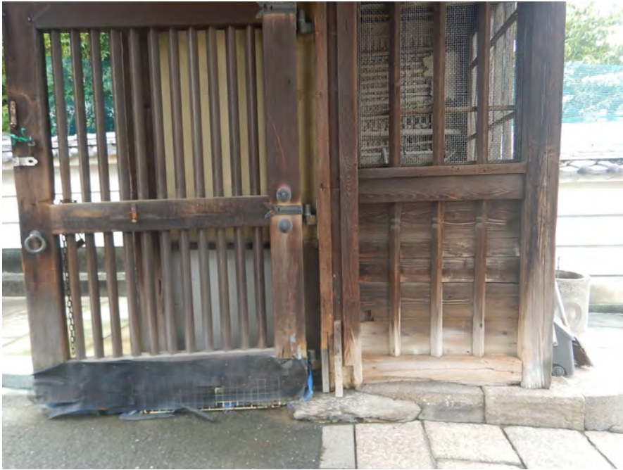
脇間 南側 扉、腰板、礎石、 敷石
