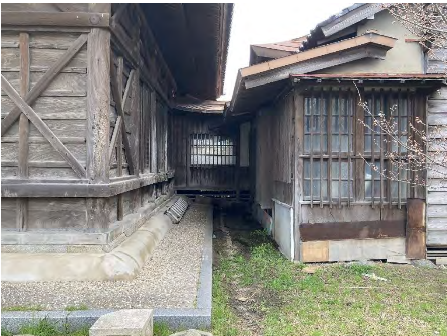
外観 背面（東寄り） 渡り廊下 北面
