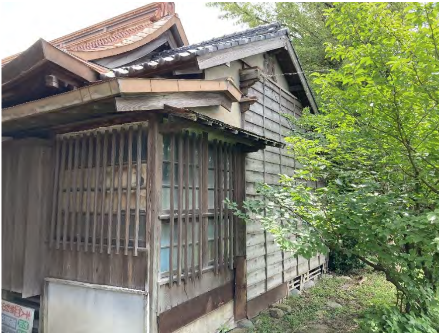
外観 背面（東寄り）
