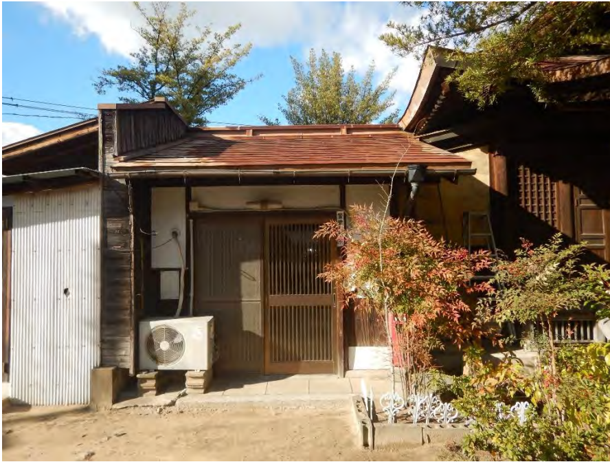
外観 管理人室 正面
