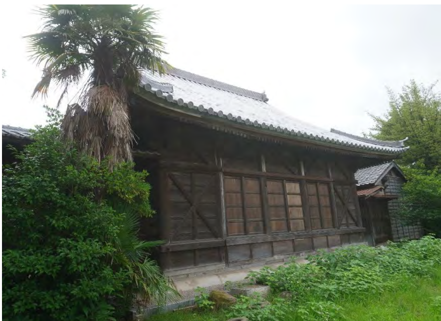
外観 背面（東寄り）
