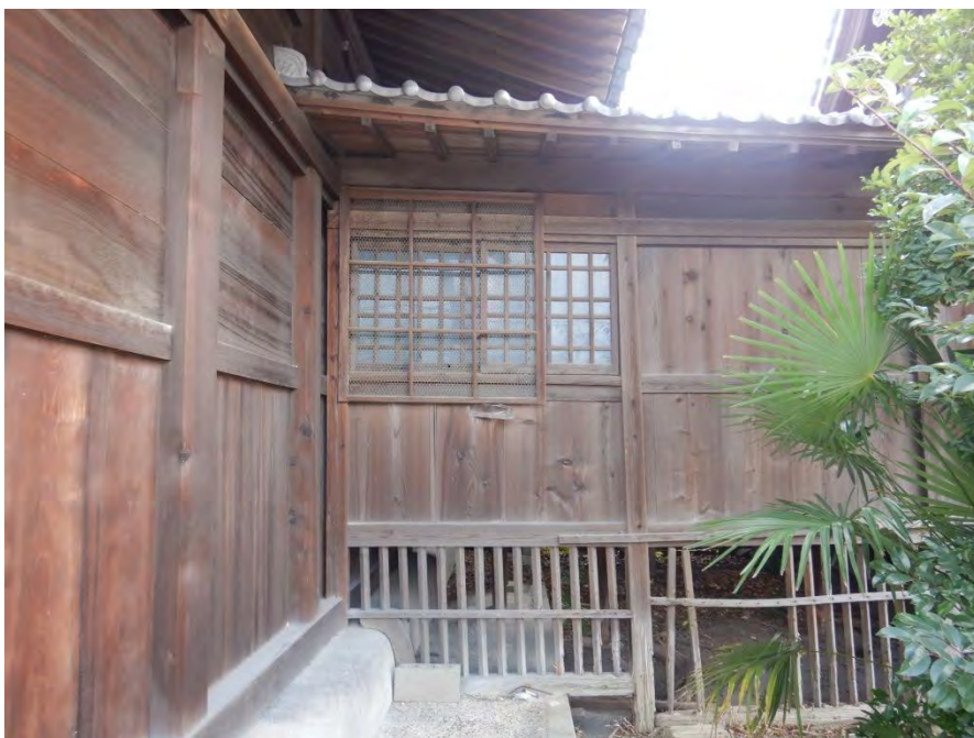
外観 渡り廊下 北側 北面
