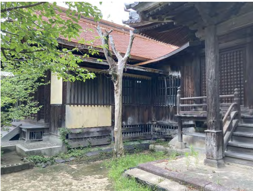
外観 側面（東面） 渡り廊下南面
