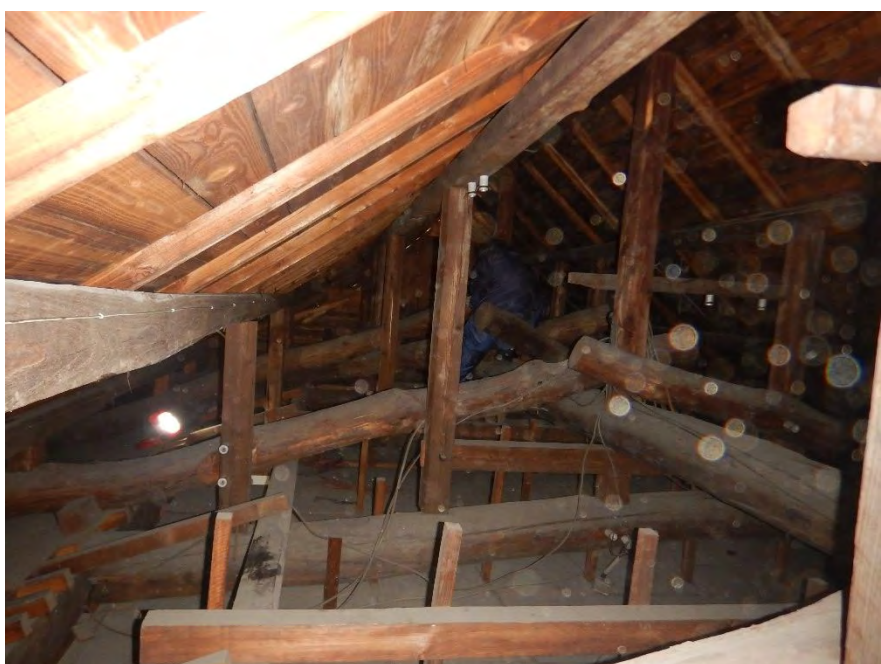
小屋裏 小屋組み
