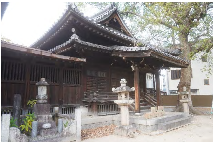
外観 正面、側面（西面） 渡り廊下 南面
