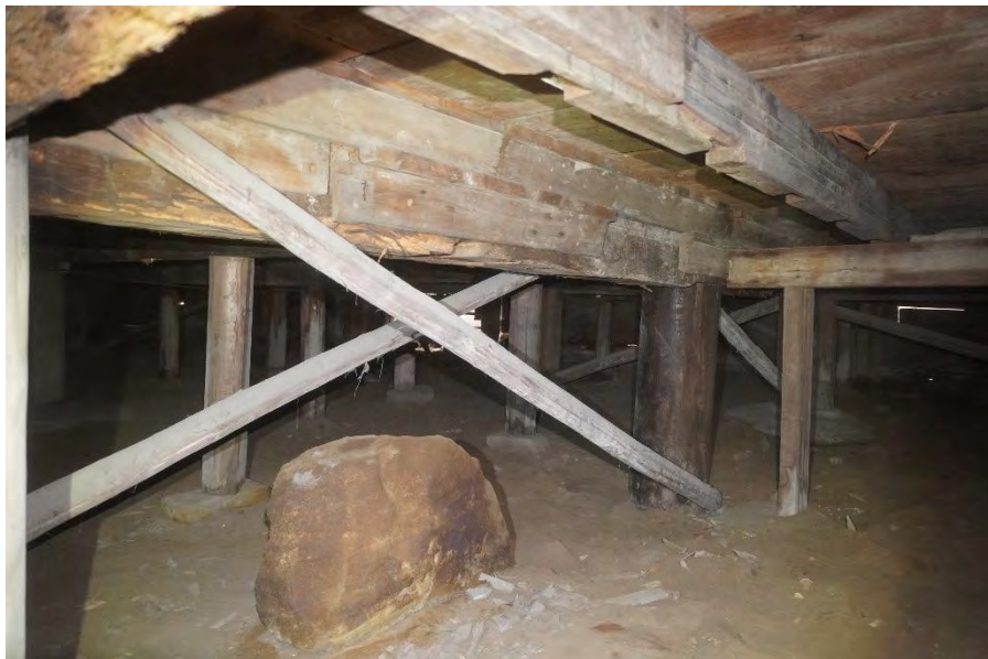
床下 床組み 内陣下
