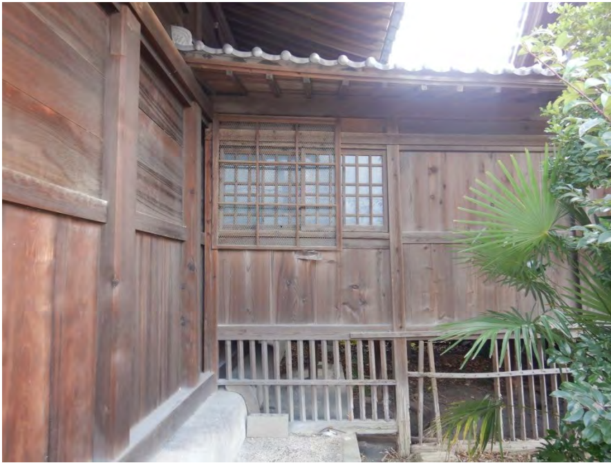
外観 渡り廊下 北側 北面
