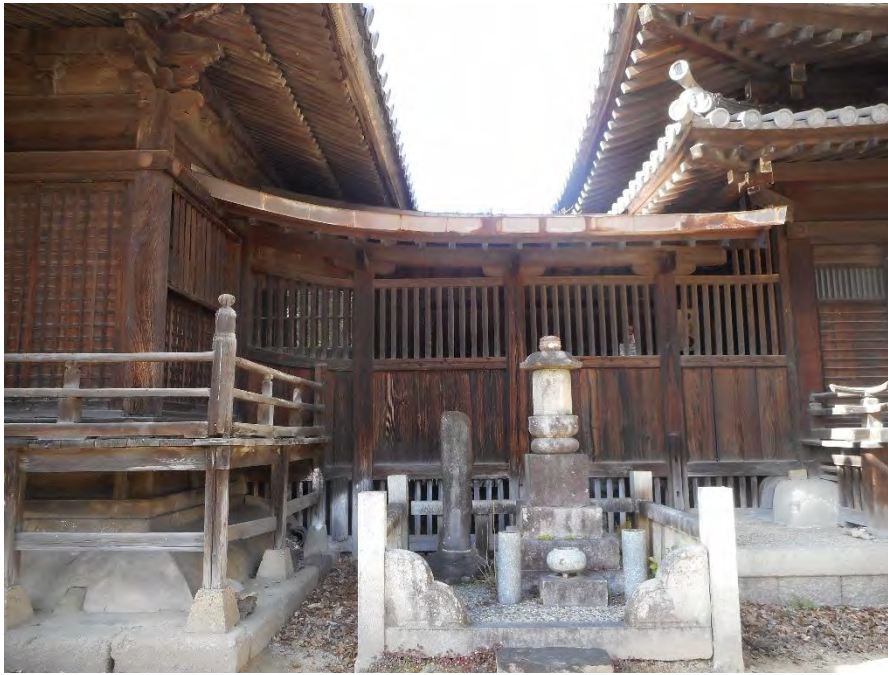
外観 渡り廊下 南側 南面
