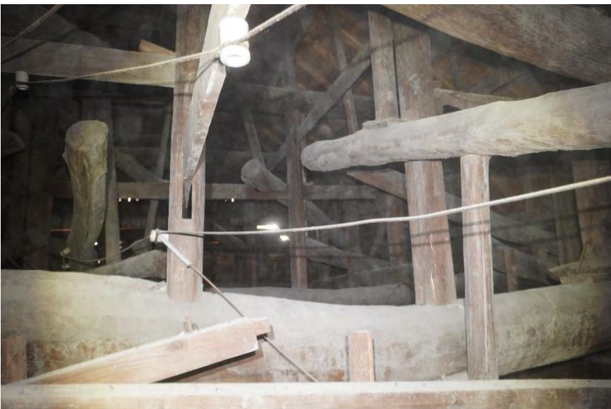
小屋裏 小屋組み
