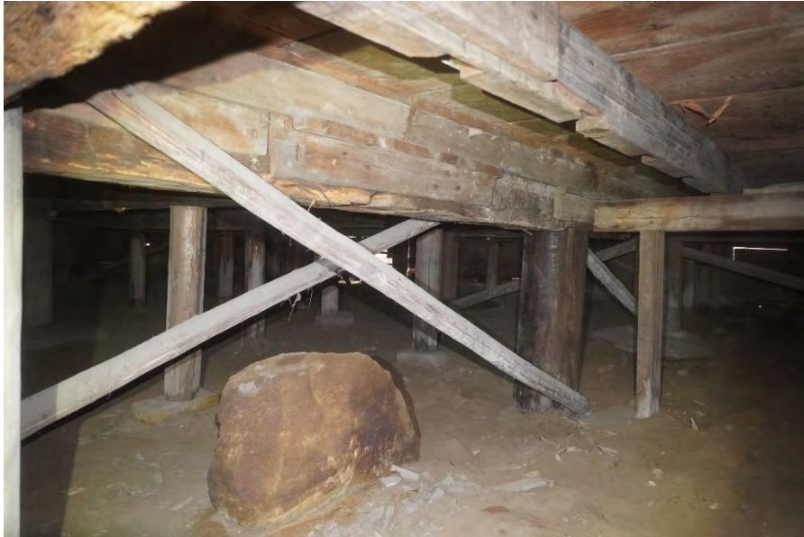
床下 床組み 内陣下
