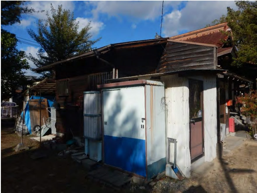
外観 管理人室、倉庫 側面（南、西面）
