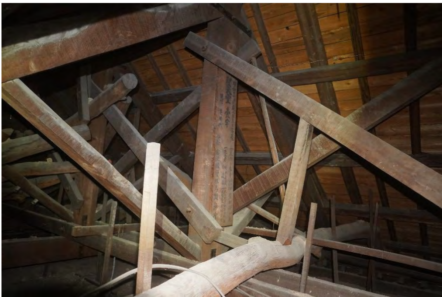
小屋裏 小屋組み トラス 棟札 昭和 10 年墨書
