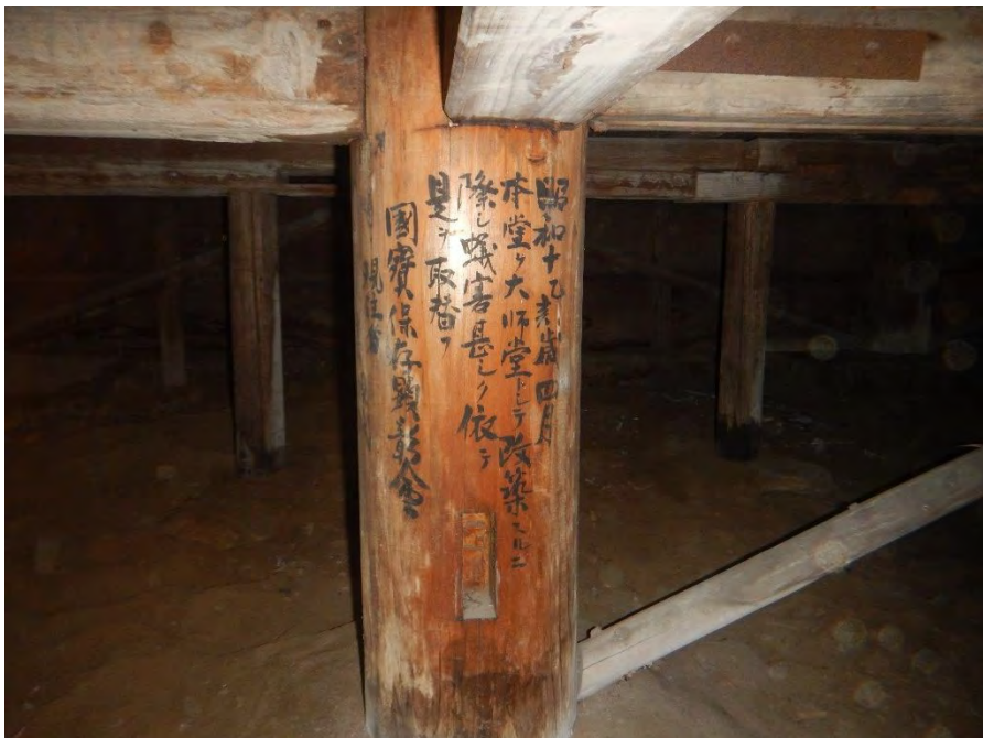
床下 柱取替え材 昭和 10 年墨書
