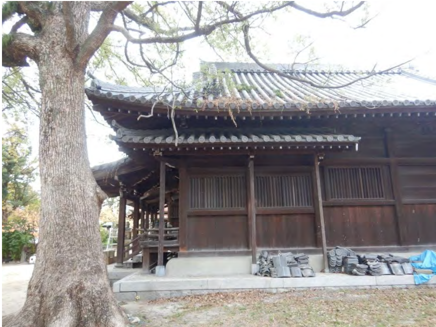
外観 側面（東面）
