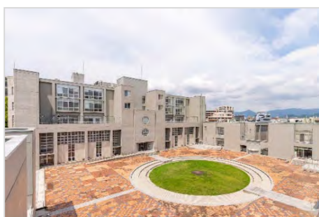
【▲写真2】旧九州芸術工科大学 音響特殊棟
