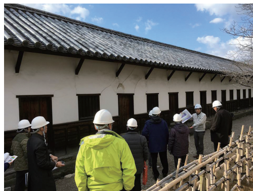
福岡城南丸多間櫓の修理
