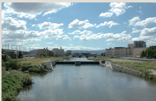
灌漑のため構築された那珂川・番託井堰
