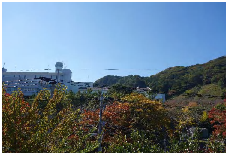
写真 3.1.5-1 (1/3) 対象事業実施区域を北北東から（撮影位置①）
