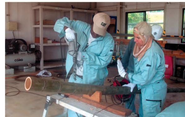
竹を利用した浸出水の集排水管の施工実習
