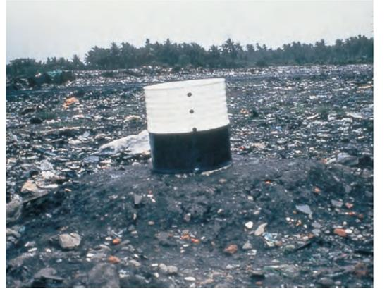
廃ドラム缶を使ったガス抜き設備
