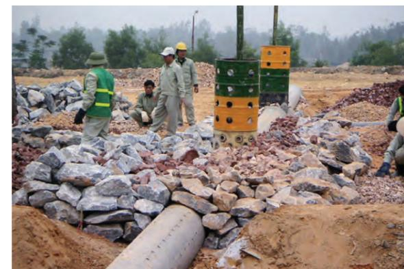
鹿ドラム缶を使ったガス抜き管の施工(ベトナム国ハノイ市ナムソン埋立場)(2005年)
