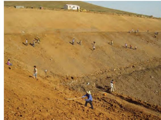
遮水シート施工前の法面の整形 (2002年)
